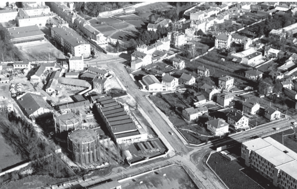
L'îlot de la Vinaigrerie en 1968 avec, au premier plan à gauche, les réservoirs de l'usine de gaz et l'usine Le Tanneur, face au lycée Quinet en bas à droite.
