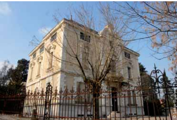
La Villa Milliat datant de 1879 et située boulevard Voltaire ne sera pas démolie.
